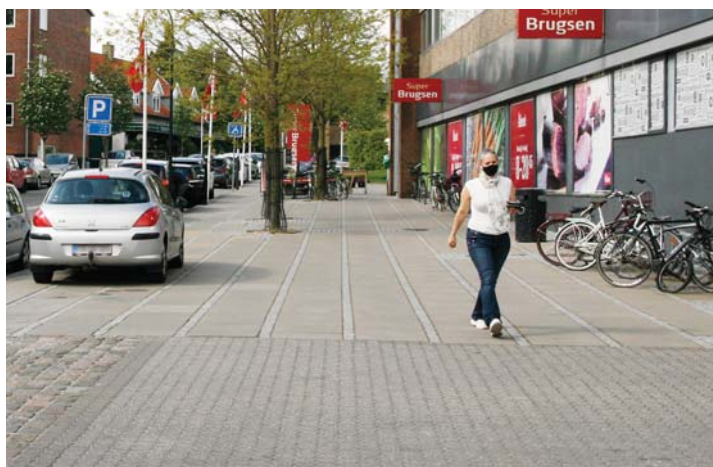
... til flisebelagt "parkeringsplads"
