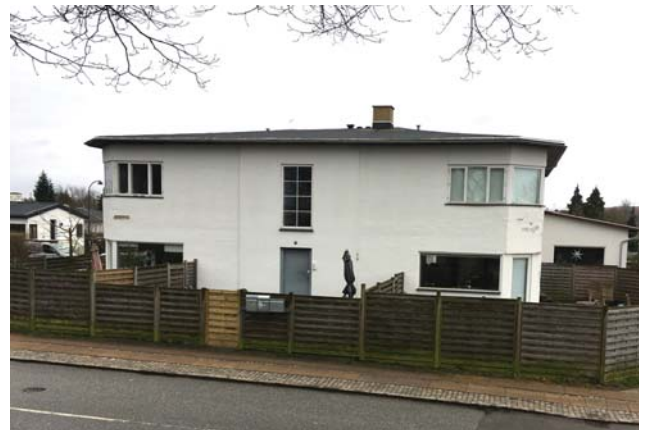
Bygningen på Mosegårdsvej 69, som den ser ud i dag. De store vinduespartier fra Tatol og mejeriet er bevaret.
