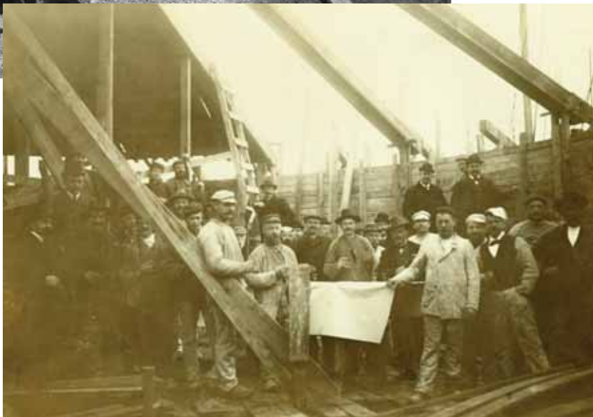
Vandtårnet under opførelse og ved rejsegilde. På øverste billede ses døromridset og granitfoden, mens flittige håndværkere er i gang rundt omkring på byggepladsen. På nedderste billede bliver der budt på 'et lille glas' til håndværkere og de fine herrer. Foto Lokalhistorisk Arkiv, Gentofte.
