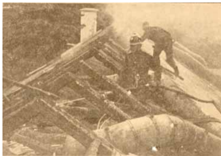
Brandmænd fra Gentofte Brandvæsen i gang med slukningsarbejdet. Foto Ekstra Bladet.
