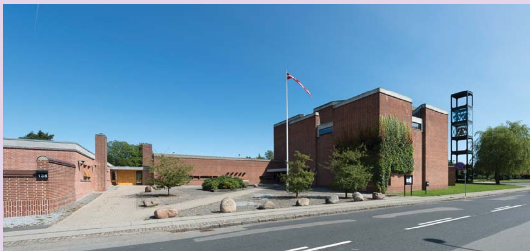
Kirken efter ombygningen i 2016
