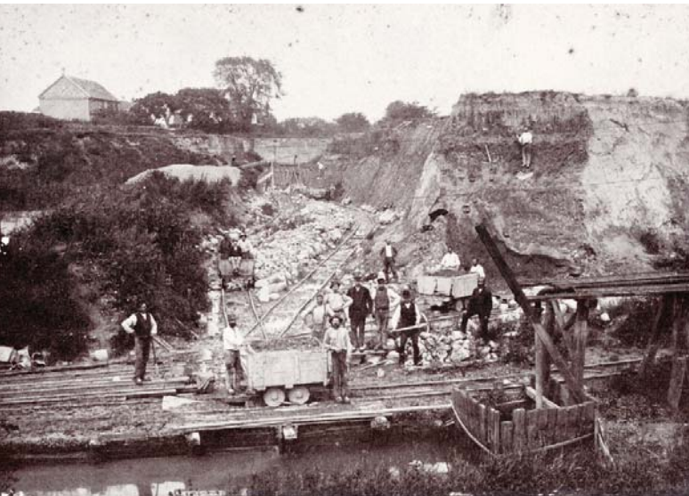
Lergraven ved Ørnegårdens teglværk. Man ser under muldlaget nogle sandlag, og under disse var der fint ler, der var velegnet til teglsten. Billedet, der er fra 1900, er opstillet med arbejdere med tipvogne til transport af leret. Kilde: LAGK
