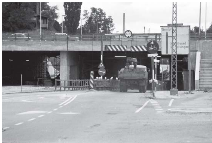
Broarbejde ved Brogårdsvej i forbindelse med udvidelse af Lyngbyvejen.
