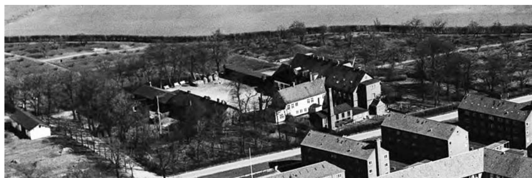
Stolpegården først i 1950-erne. Læg mærke til vaskeribygningen med høj skorsten ud mod Stolpegårdsvej. Efter renovering indrettede Gjentofte Kommune alderdomshjemmet Vesterled i bygningerne.
