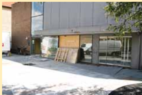
Caféen er stadig under ombygning, men står klar til indvielse sidst på måneden.
