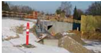
Den nybyggede bro over Vinagervej set fra Lyngbyvejen. Foto NUKH
