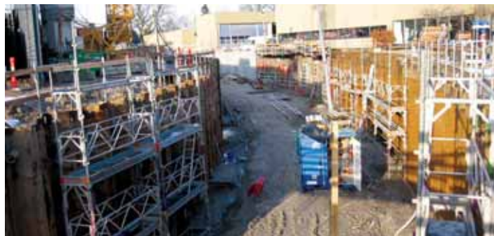
Nedkørselsrampen til M3, hvor den nye bro til genbrugspladsen skal være. Foto NUKH
