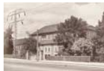
Den i 1994 nedrevne transformatorstation "Ørnegården" fotograferet tværs over en fredelig Lyngbyvej. Kilde: NESA.1902-1952 side 83.
