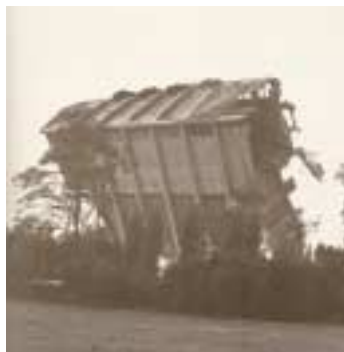
Forbrændingsanlægget er ved at styrte sammen efter bortsprængning af fundamentet. 1971. Kilde: Gentofte Kommunens Tekniske Forvaltning 1976 s. 21.
