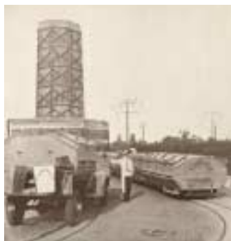
Det kommunale forbrændingsanlæg på Ørnegårdsvej. Omlæsning fra lastbil til tipvogn, foto fra ca. 1950. Kilde: Gentofte kommune. Teknisk Udvikling siden 1901. side 85. 1951.
