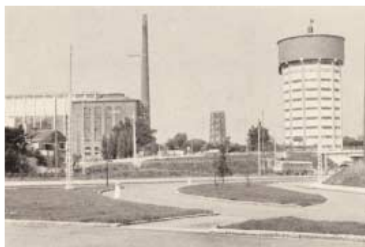
Vandtårnet og det udvidede forbrændingsanlæg set henover Sløjfen og motorvej, hvor Sølvbussen til Nærum og Gammel Holte havde holdeplads. Kilde: Gjentofte kommunestyre 1942-67 side 117.
