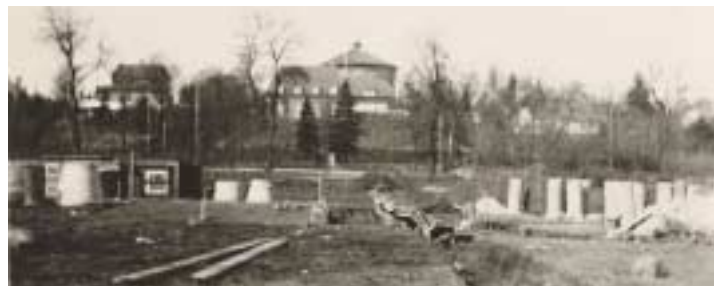
Søbredden anlægges 1935. Ræveskovsvandtårnet ses i baggrunden. Foto Privateje.
