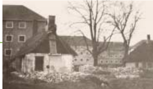
Foto af Brogårdens nedrivning i 1944 i forbindelse med opførelsen af boligblokkene langs Lyngbyvej. Foto: Lokalhistorisk Arkiv, Gentofte.
