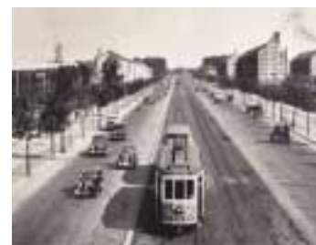
Foto af Lyngbyvejen fra den dengang nyopførte jernbanebro mod nord ud af Lyngbyvejen. I midten ses sporvogne, dernæst 2 kørebaneer med trolleyledninger dernæst cykelstier og fortorve. Bemærk de nyplantede vejtræer.
