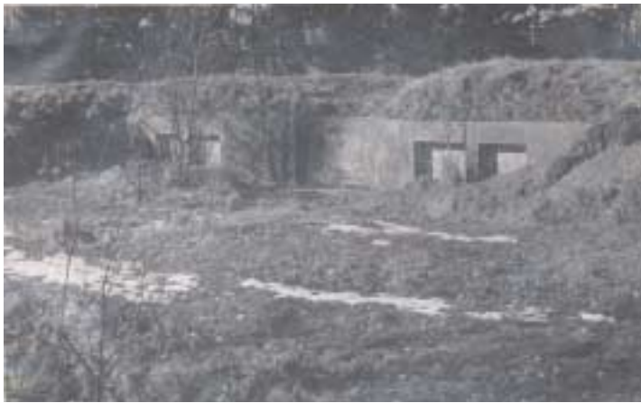
Betonbriske fra Vangede Batteri
